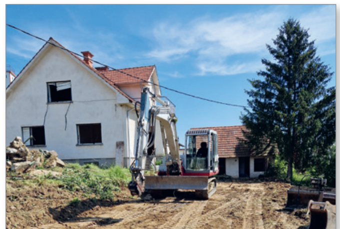
Odstranitev objektov na zemljišču za parkirišče. Foto: V. K. in D. P.
