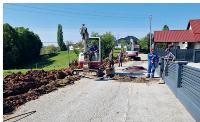
Gradnja optičnega omrežja v naselju Smolinci-Župetinci
