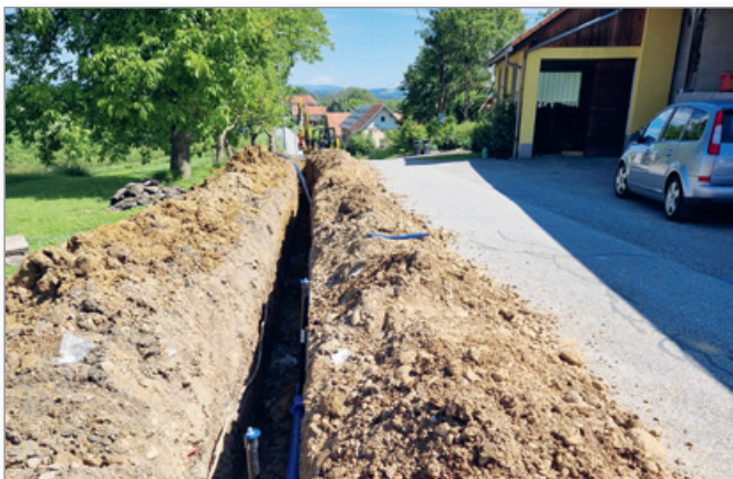
Obnova vodovoda Cenkova-Cogetinci
