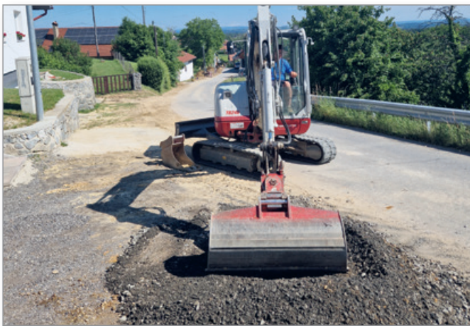
Gradnja optičnega omrežja v naselju Cenkova-Cogetinci
